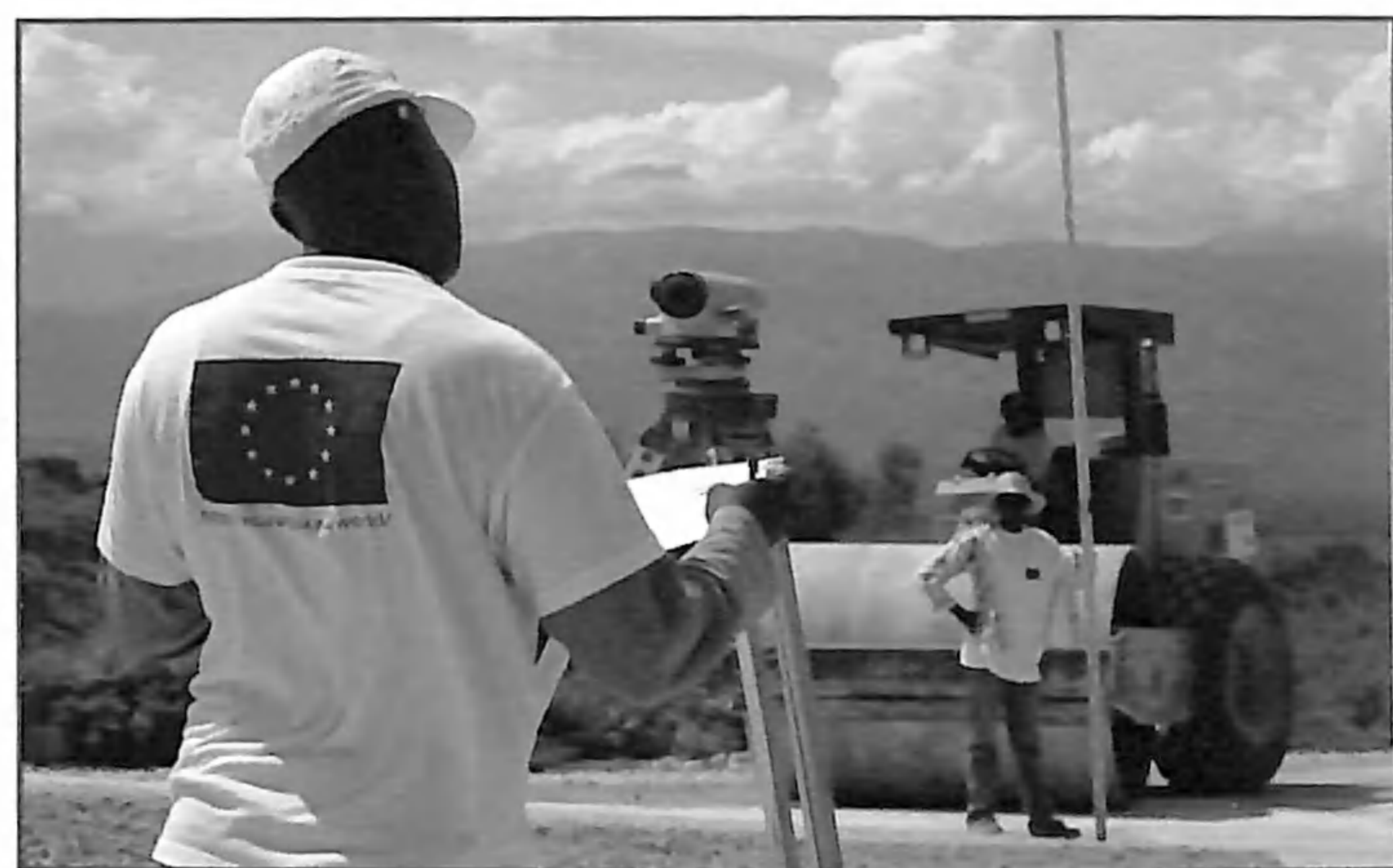
Rehabilitación de la carretera nacional 3, Haití
